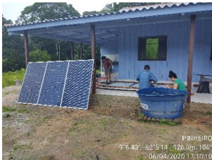
Figura 11 - Instalação do kit de energia solar em abril de 2020
