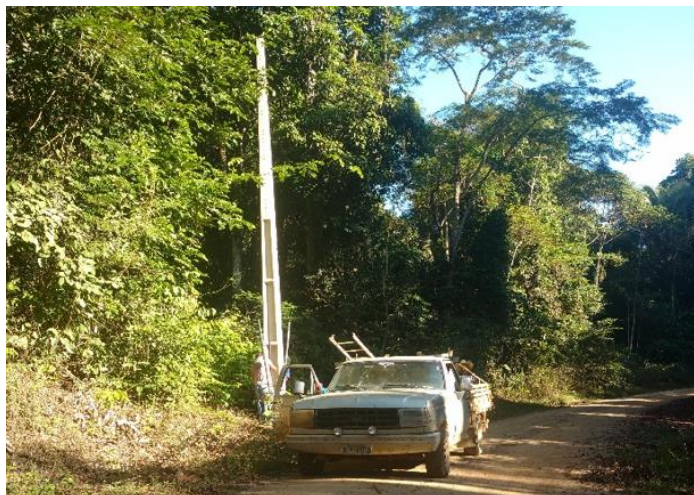
Figura 10 - Instalação de rede elétrica na RESEX Rio Preto-Jacundá.
