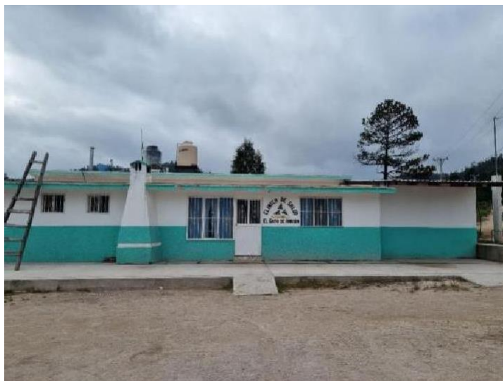
Clínica de salud ubicada en el anexo El Gato
